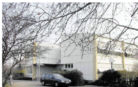
SÜDWESTLICH an den Haupteingang wird sich der Schulanbau (zwei Stockwerke plus Kellergeschoss) mit der Mensa anschließen. Damit wird die Adolf-Kußmaul-Schule für den Ganztags-Schulbetrieb fit gemacht. Die Gesamtkosten werden sich auf rund 2,38 Millionen Euro belaufen.
